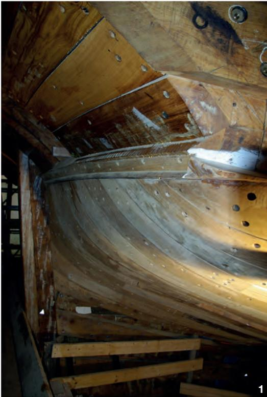
1. Pour l'arcasse sur l'arrière, la remontée des bordages est si forte, qu'il n'a pas été possible de ployer à la vapeur des pièces de 74 mm d'épaisseur ; ces bordages ont alors été réalisés en lamellé collé de chêne. Autrefois étaient utilisés des bois déjà en forme de pipe.
