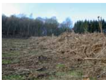
Nettoyage des rémanents au râteau andaineur : décapage des horizons organiques et compactage des horizons superficiels préjudiciables pour la reprise et la croissance des plants.
