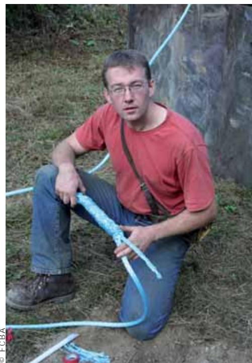
*En 12 minutes et sans outillage particulier, il est possible de réparer le câble sur le terrain.*
