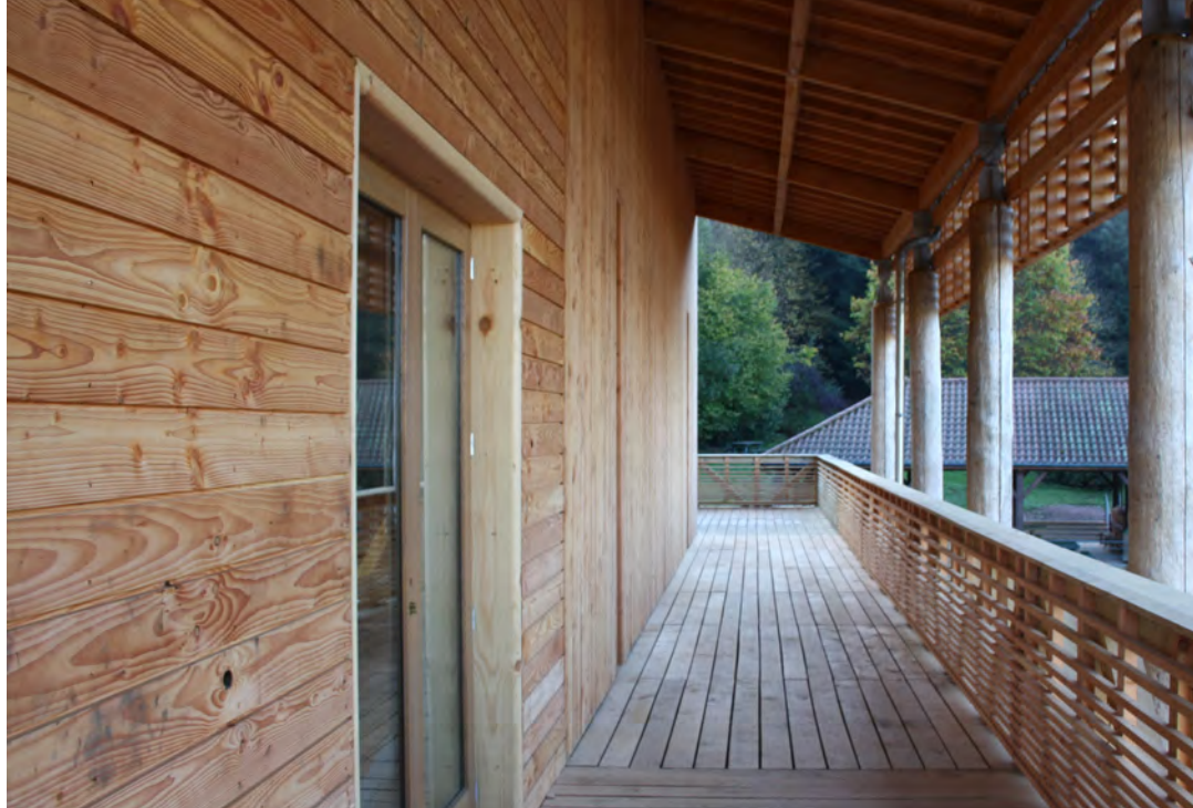
Une ancienne grange en cours de rénovation avec un bardage douglas en vue de la réhabiliter en gîte rural.
