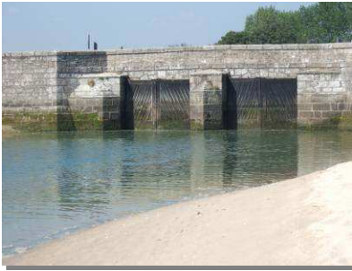
Portes à flots du pont de Saire
