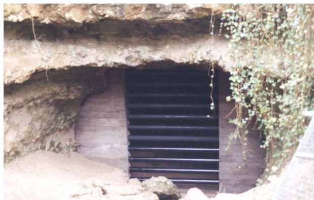
Photo 3 : après les travaux
