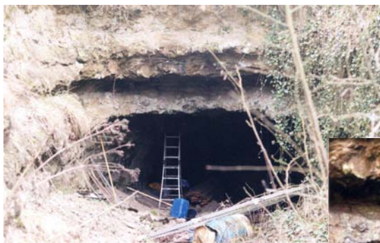
Photos 1 et 2 : pendant les travaux
