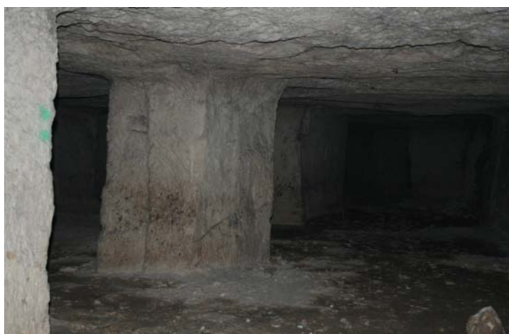
Vue de l'intérieur de la cavité
