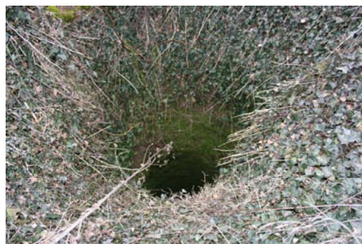
Cheminée vue depuis l'extérieur
